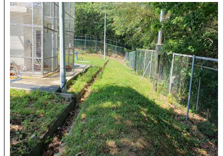
<부대시설 배수로 전경>
