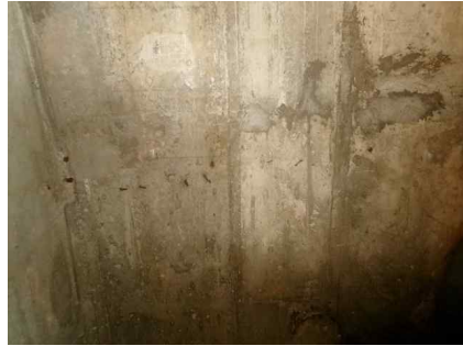
<유입밸브실 벽체 상태양호>
