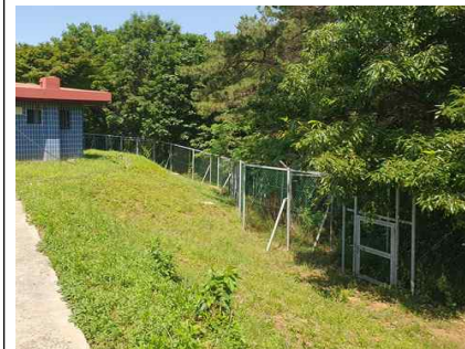
<부대시설 안전헨스 상태현황>
