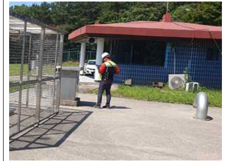
<외부 개별부재 외관조사>
