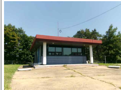
<건축동 외부 전경>
