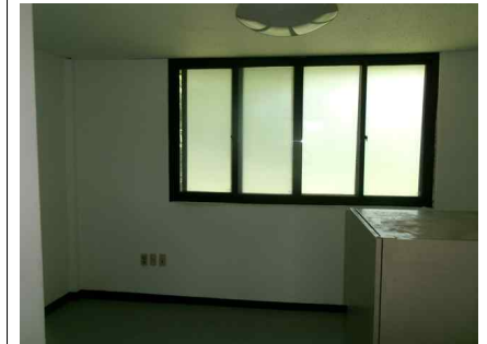
<전기실 내부 상태현황>
