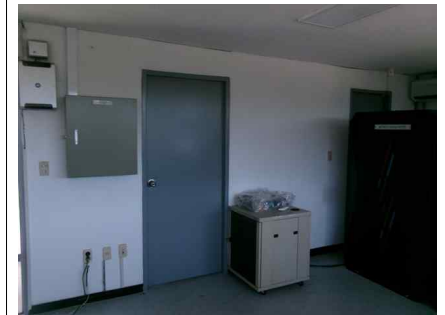
<전기실 내부 상태현황>
