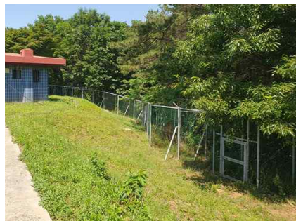
<부대시설 안전펜스 전경>
