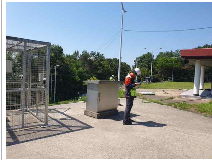
<외부 개별부재 외관조사>
