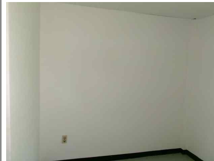
<전기실 내부 상태현황>
